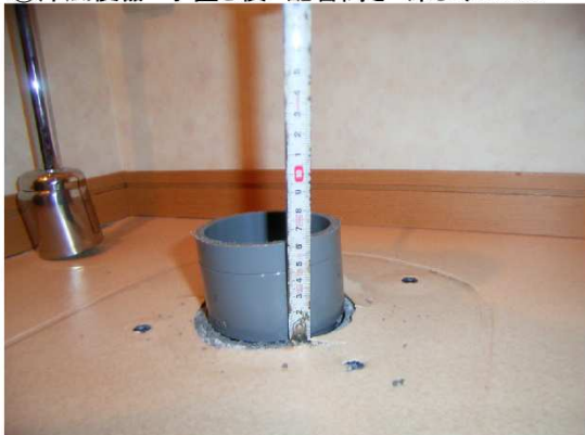
②洋風便器 手直し後 配管高さ 床より65mm
