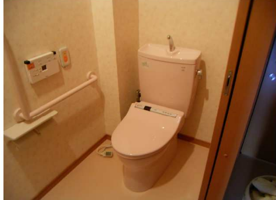
④洋風便器 復旧
