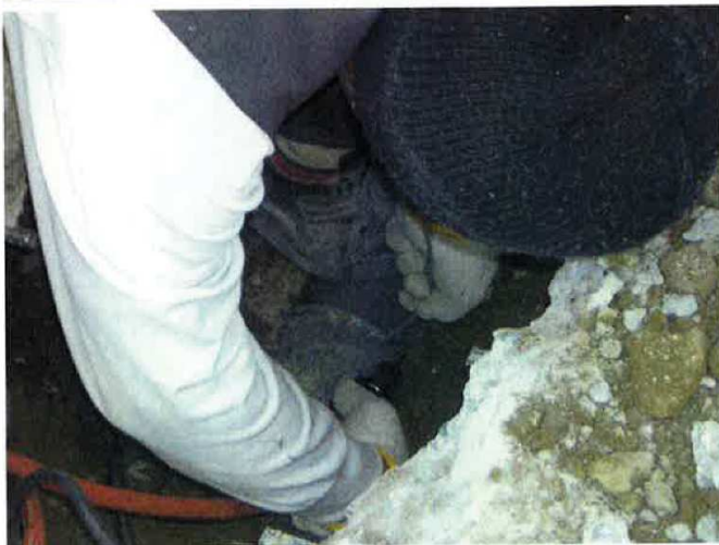
改修後 塩ビ溶接
